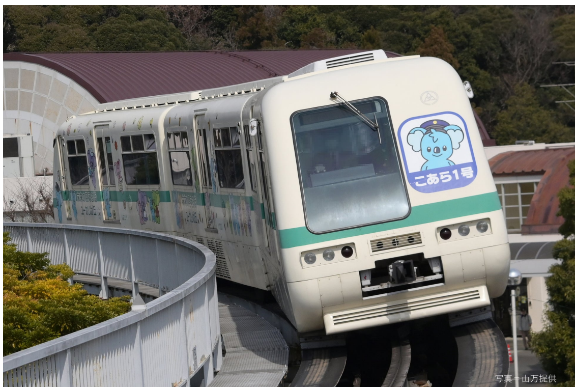
関東で初めてのAGT（自動案内軌条式旅客輸送システム）として開業した山万 ユーカリが丘線
